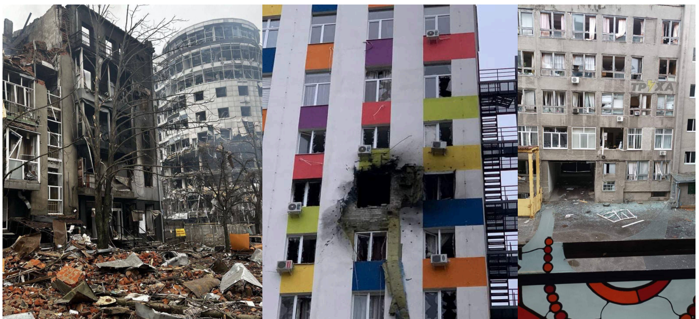
Zerbombte Häuserfassaden in Charkiw
